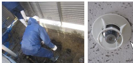
↑ケアホーム敷地内の水道管を調整しています。
